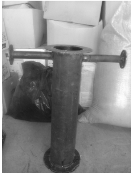
Obr. 3 Realizácia filtračného zariadenia
